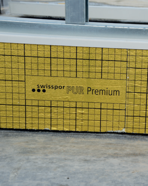
Sockel beim Stahlbau im Attikabereich (Terrasse) gedämmt mit swissporPUR Premium und der anschliessenden Aufbordsabdichtung 1. Lage mit einer Selbstklebebahn swissporBIKUPLAN LL Vario v ausgeführt. Die Klebeseite wird vorgängig mit der Flamme aktiviert.
