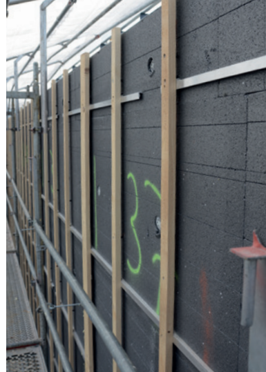
fertige Holzunterkonstruktion
