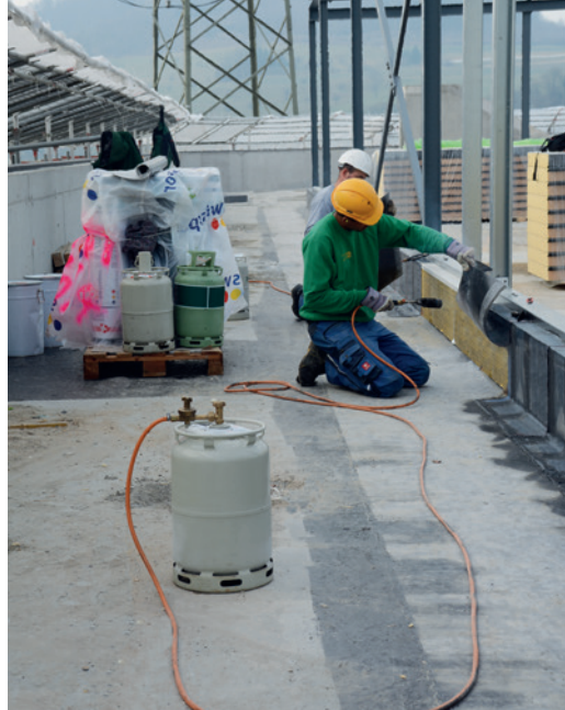
Sockel beim Stahlbau im Attikabereich (Terrasse) gedämmt mit swissporPUR Premium und der anschliessenden Aufbordsabdichtung 1. Lage mit einer Selbstklebebahn swissporBIKUPLAN LL Vario v ausgeführt. Die Klebeseite wird vorgängig mit der Flamme aktiviert.
