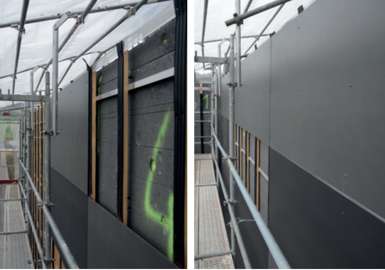
Bekleidung mit Swisspearl LARGO auf Traglattung montiert
