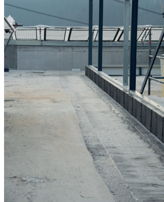
Sockel beim Stahlbau im Attikabereich (Terrasse) gedämmt mit swissporPUR Premium und der anschliessenden Aufbordsabdichtung 1. Lage mit einer Selbstklebebahn swissporBIKUPLAN LL Vario v ausgeführt. Die Klebeseite wird vorgängig mit der Flamme aktiviert.
