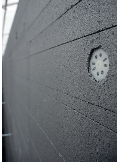
swissporLAMBDA Vento mit Dämmstoffhaltern an Betonaussenwand befestigt
