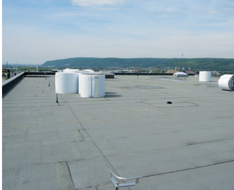
Ansicht Hauptdach Technikzentrale mit fertig verlegter Dampfbremse swissporBIKUTOP EP5 S flam und anschliessend fertig erstellter bituminöser Abdichtung aus swisspor BIKUPLAN EGV3.5 v flam und swissporBIKUTOP EP5 WF S flam bereit zur Verlegung der Drainageschicht
