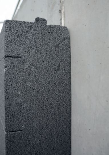
swissporLAMBDA Vento mit Dämmstoffhaltern an Betonaussenwand befestigt
