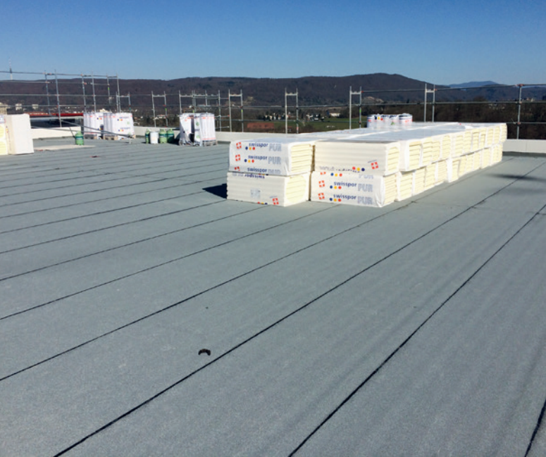
Ansicht Hauptdach Technikzentrale mit fertig verlegter Dampfbremse swissporBIKUTOP EP5 S flam und anschliessend fertig erstellter bituminöser Abdichtung aus swisspor BIKUPLAN EGV3.5 v flam und swissporBIKUTOP EP5 WF S flam bereit zur Verlegung der Drainageschicht
